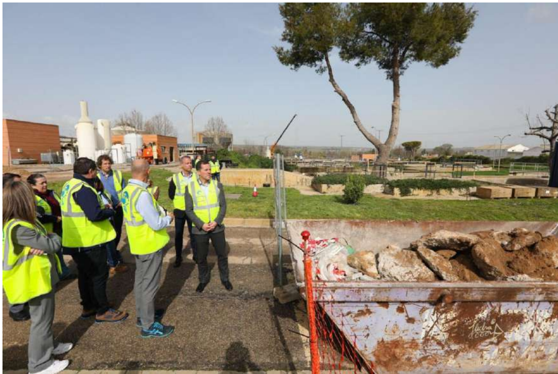
Carlos Velázquez ha visitado las obras de la EDAR de Santa María de Benquerencia, donde se destinan 3 millones de euros para transformar por completo la instalación
